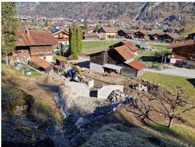
Entlastungsbauwerke im Bau am Milchbach
