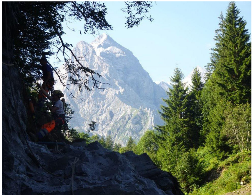
Arbeiten an der Felsnase nach dem Täfelrain - mit prächtigem Panorama und Sicht auf das Wellhorn.
