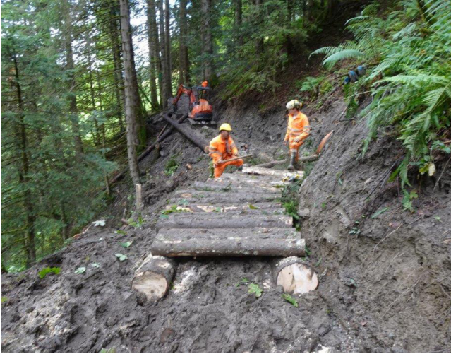
Arbeiten im Morast - mit einem Holzsteg und Kies wird die nasse Stelle überwunden.
